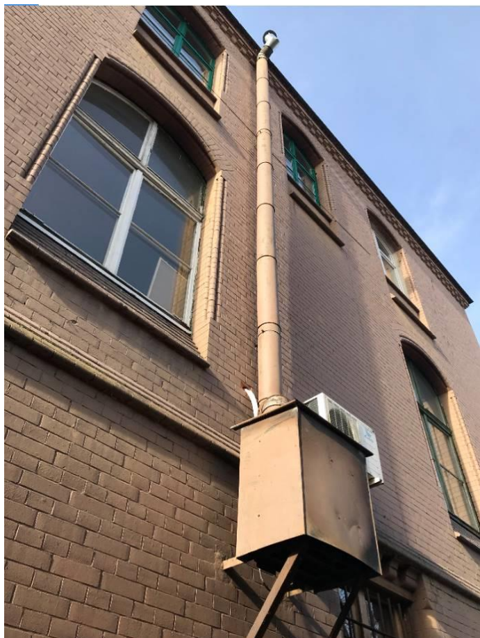
Zdj.5. Elewacja zachodnia.
