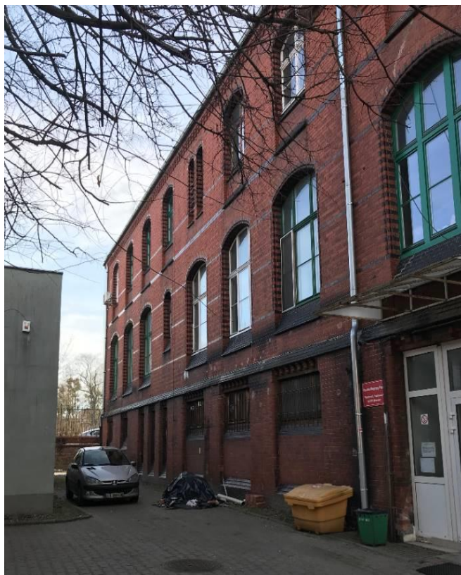
Zdj.7. Elewacja północno-zachodnia
