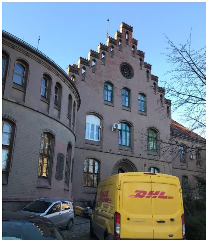
Zdj. 1. Wejście główne do budynku
