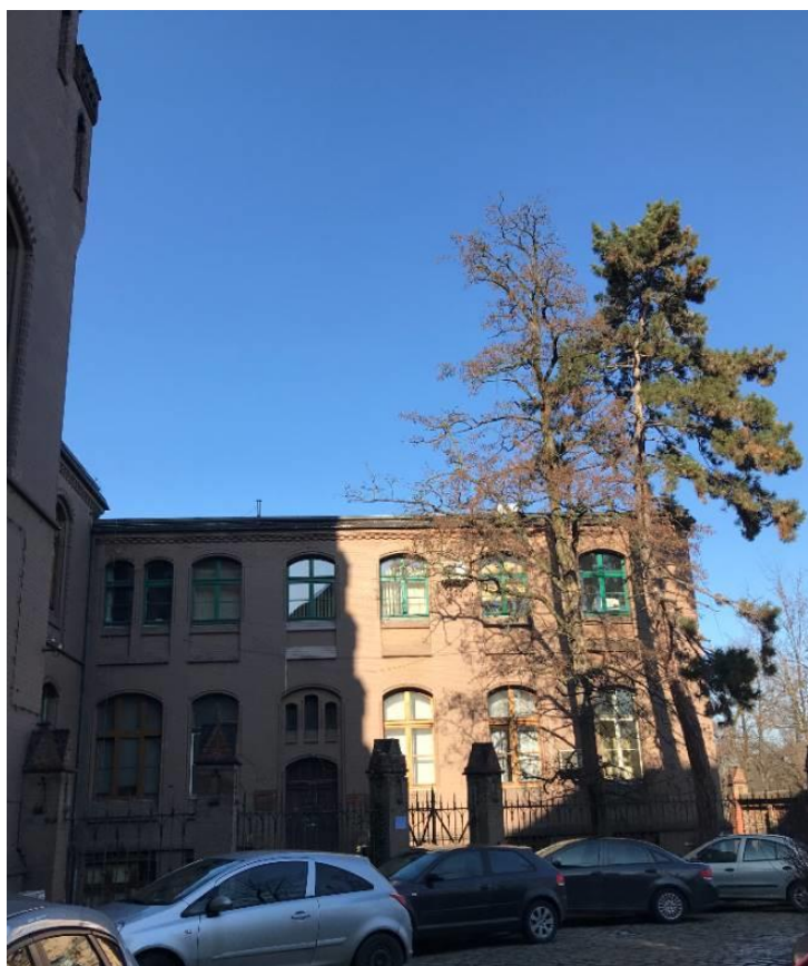
Zdj. 2. Elewacja południowa, na parterze znajduje się obecna Medycyna Pracy i Genetyka.
